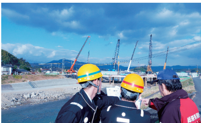
日田市内の鉄道落橋現場を視察する奥野総務副大臣（一番右）
