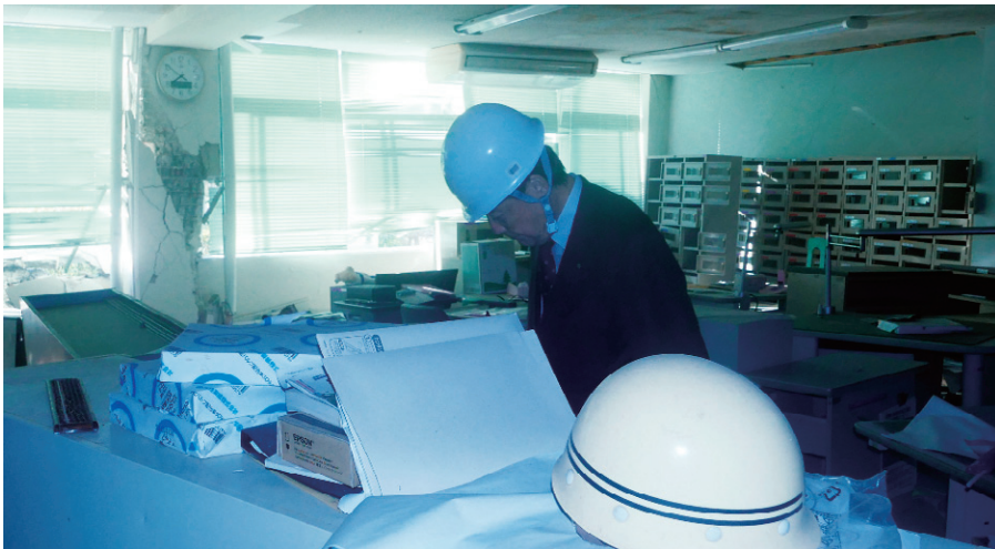
災害発生現場（東南海大学阿蘇キャンパス内）を視察する奥野総務副大臣
